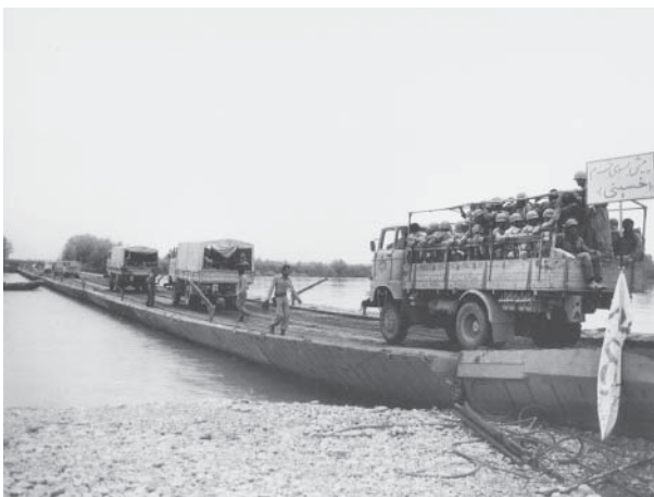
یکی از پنج پل شناور نصب‌شده روی رودخانه کارون در عملیات بیت‌المقدس
